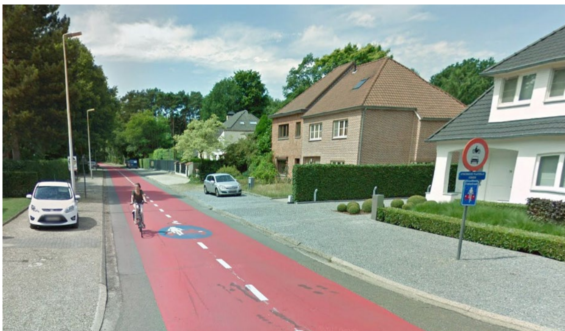
— FIGURA 2: IMAGEN DE GOOGLE STREETVIEW DE REINPADSTRAAT, EN GANTE, BÉLGICA —
