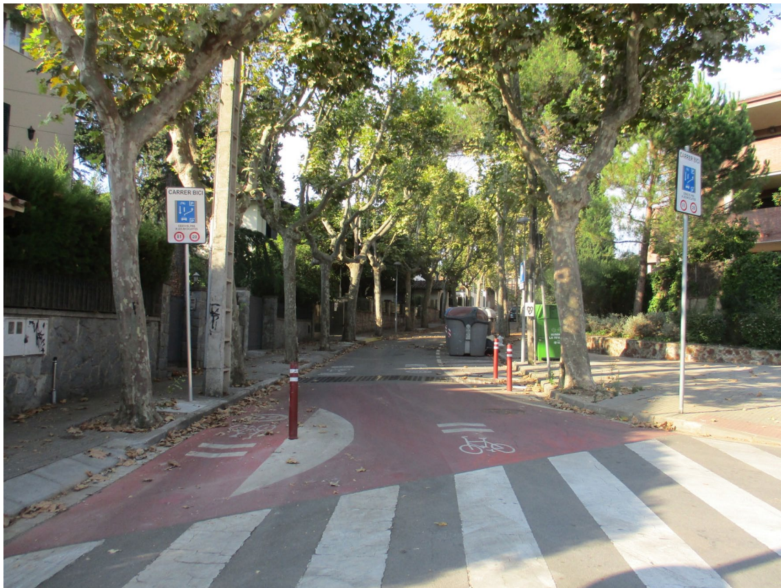
— FIGURA 6: IMATGES DEL 'CARRER BICI' IMPLANTAT AL PG. VALLDOREIX DE SANT CUGAT —
